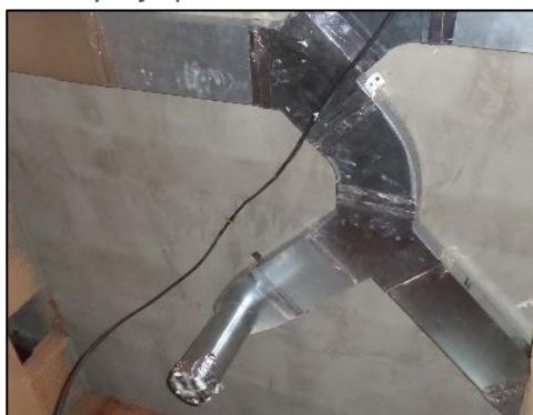
Montáž ve stropě
